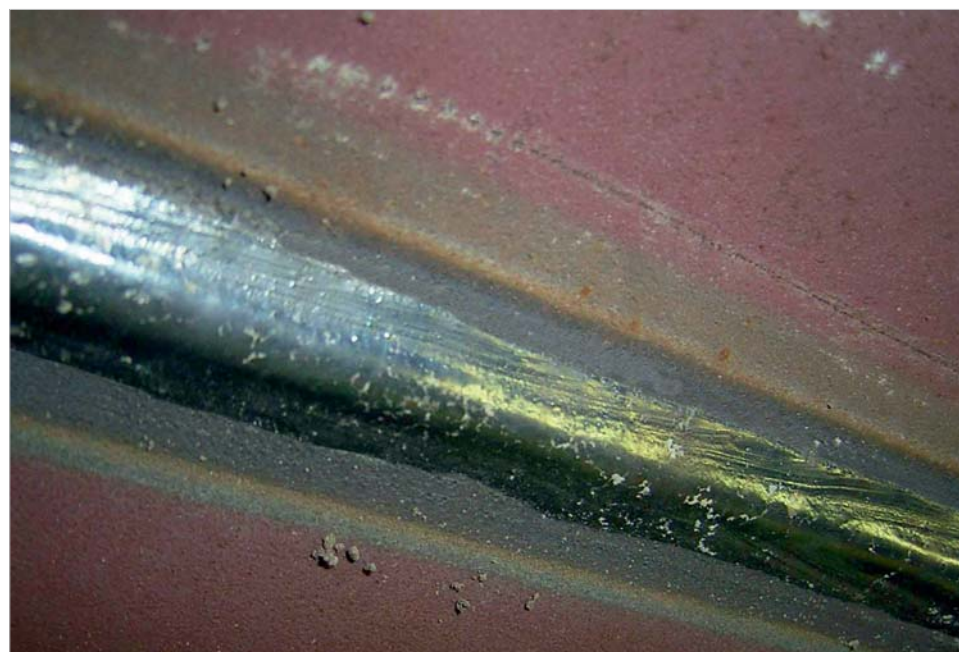
Нижняя сторона одностороннего шва, выполненного на флюсовой подкладке из ОК Flux 10.69
