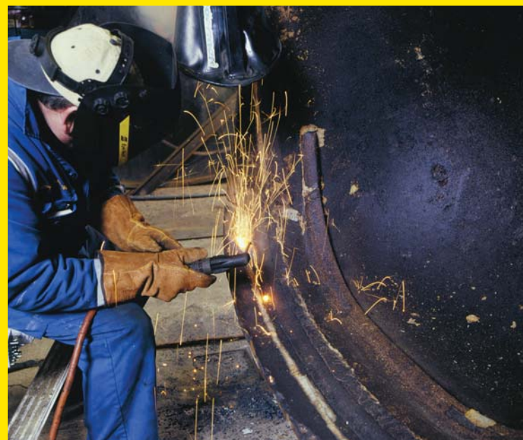
Сварочные материалы для ремонтно-восстановительных работ
