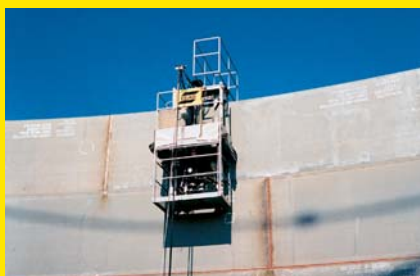
Оборудование для сварки резервуаров
